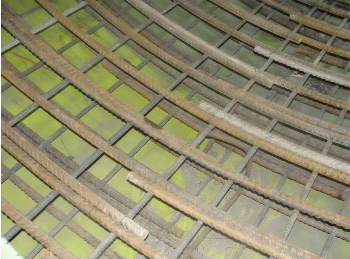
وأخيرا تبدأ عملية الصب بواسطة قوالب كونكريتية جاهزة و يتم حفر الجزء السفلي لإكمال المقطع المصمم حيث نستخدم خرسانة ضعيفة (blinding) . سمك التبتين الكلي (50cm).
