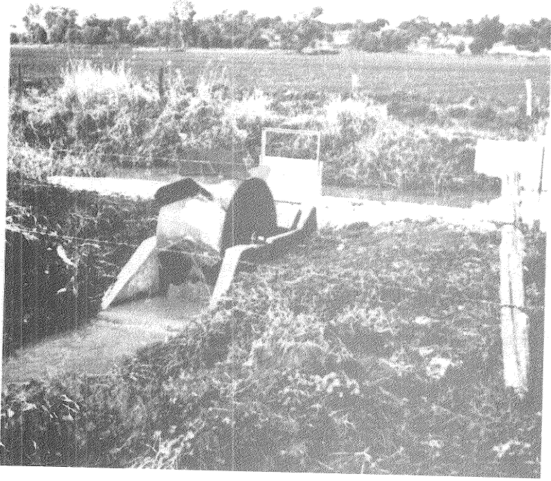
الصورة 9.2 مقياس دثريج (سعة ٢ قدم ٣ / ٥) لاغراض الري في منطقة نيودور كويتزلاند.
