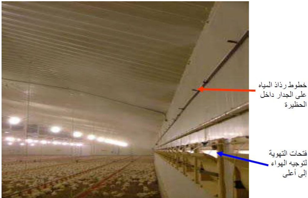
الشكل يوضح نظام التبريد برذاذ الماء (الضباب) داخل الحظيرة وفتحات التهوية
