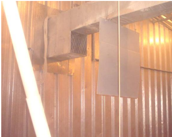
الشكل يبين موجبات الهواء البارد داخل الحظيرة المندفعة من مبردة الهواء للتقليل من التيارات الهوائية الباردة المباشرة
