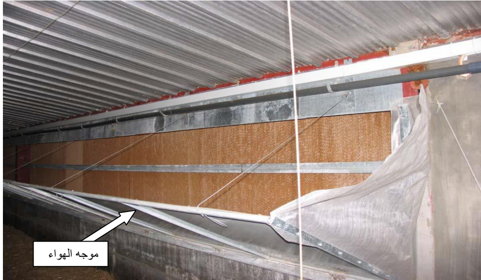
الشكل يبين موجهات الهواء البارد داخل الحظيرة Air deflectors
