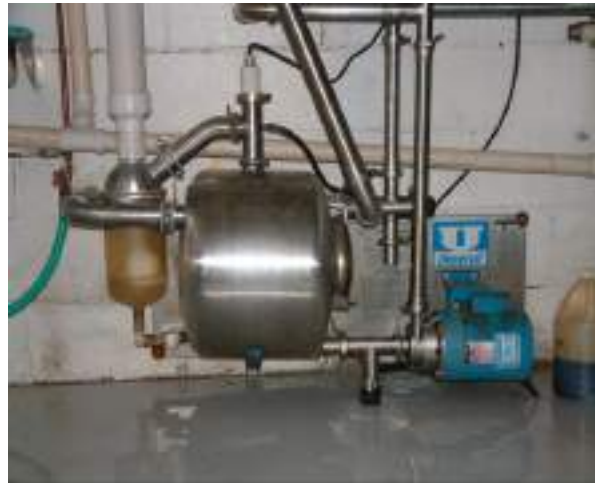
شكل ( 9 - 8 ) مضخة التفريغ مع مقياس مستوى تخلخل الضغط
