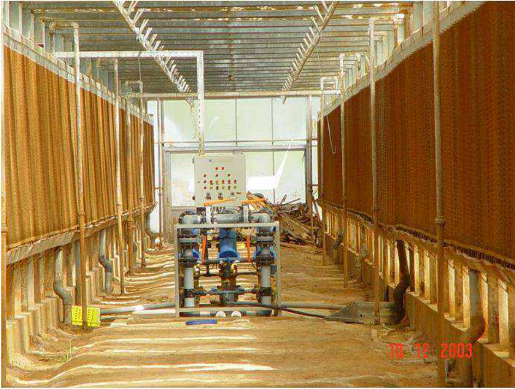
صورة ( ) توضح نظام التبريد التبخيري في البيوت المحمية
