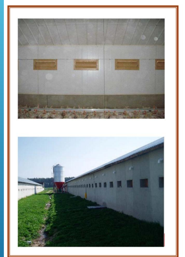
شكل رقم ( ١٤ ) يبين توزيع فتحات التهوية على جانبي الحظيرة من الداخل والخارج ، وفتحات دخول الهواء
