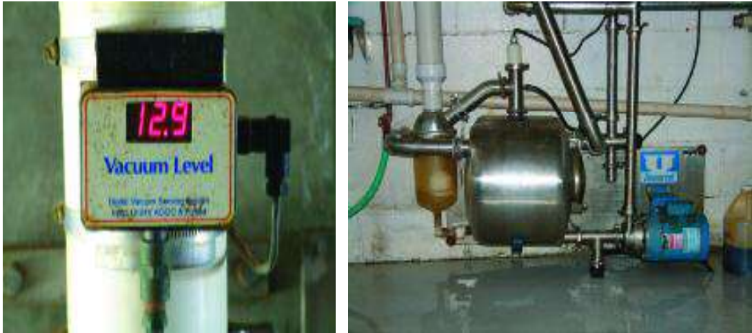
شكل ( 9 - 8 ) مضخة التفريغ مع مقياس مستوى تخلخل الضغط
