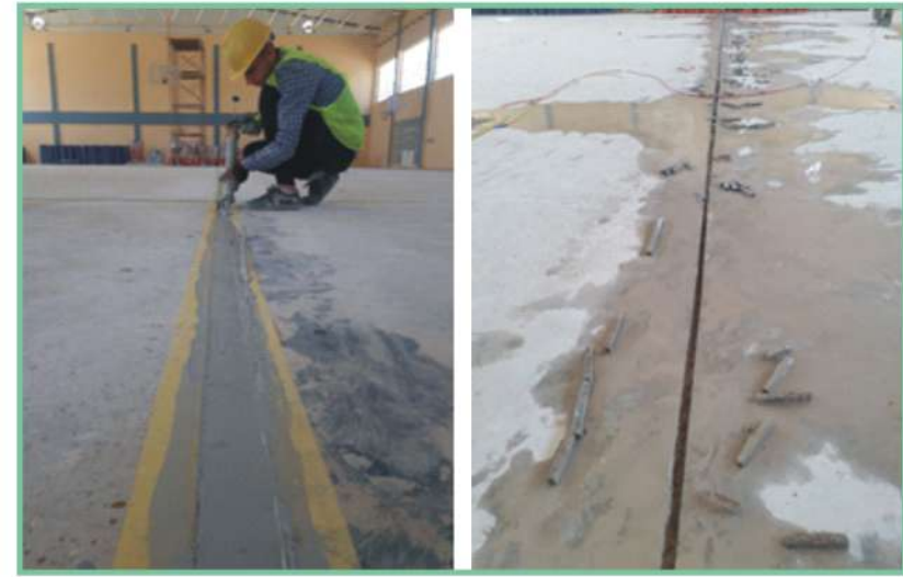
تنظيف الفواصل وملئها بواسطة الصوصج
