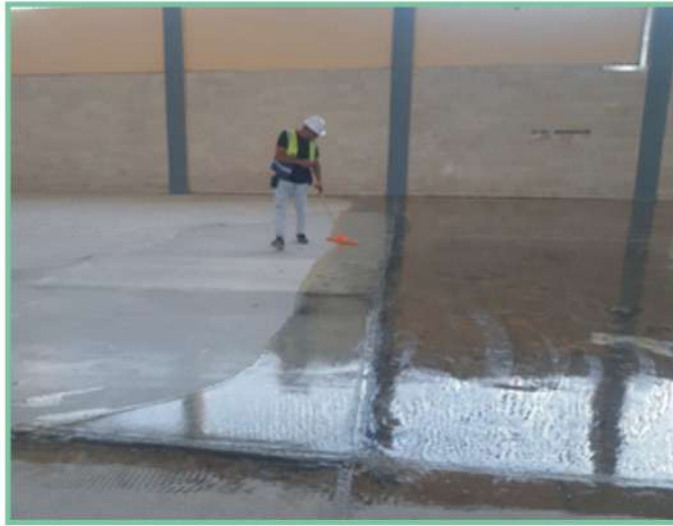
تصليح الأرضية بواسطة ال self leveling
