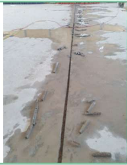
تنظيف الفواصل وملئها بواسطة الصوصج
